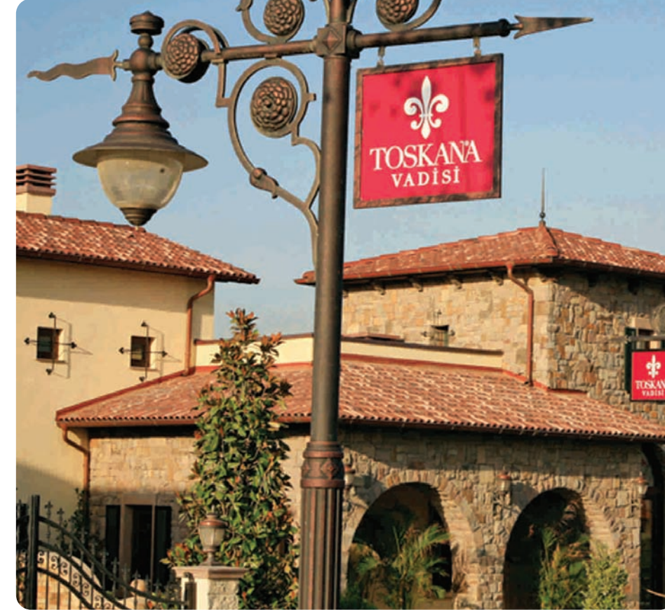
Emaar Turkey Toskana Vadisi Bakır Yağmur İndirme Sistemleri
